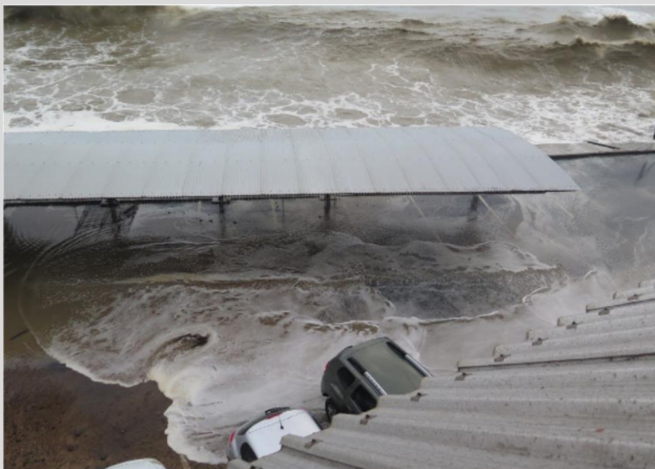
Submersion sur le parking de la DGTM en 2016, PPRIL Île de Cayenne
