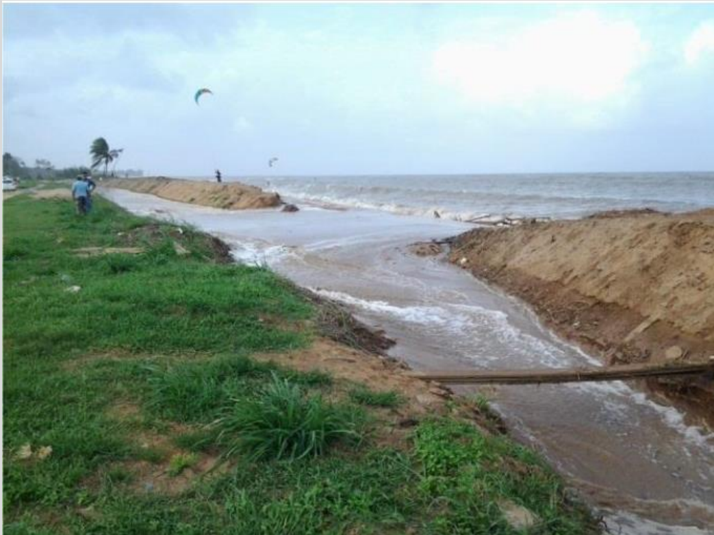
BRGM, Infiltration d'eau dans la passe du merlon érigé contre les risques de submersion en octobre 2015
