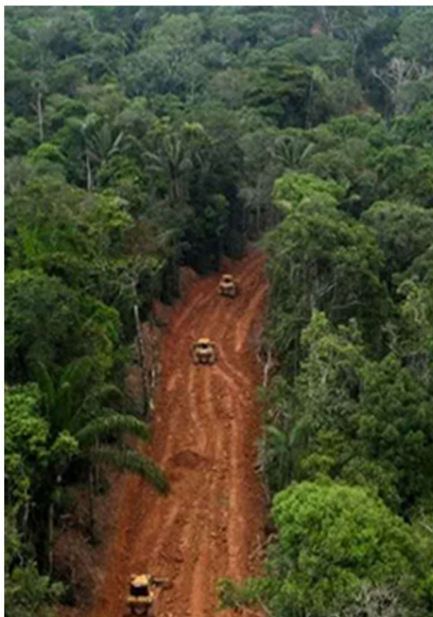
Construction d'une route
