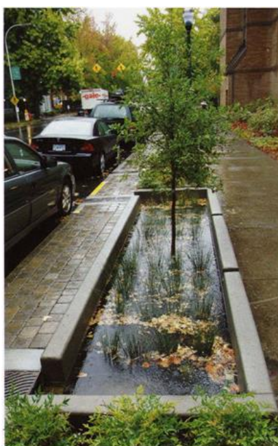
Exemple de rétention des pluies d'orages en intégrant des aménagements au sein des espaces publics - réduction des pollutions, du ruissellement en ville et contrôle du débit (source : Portland dans l'Oregon)
