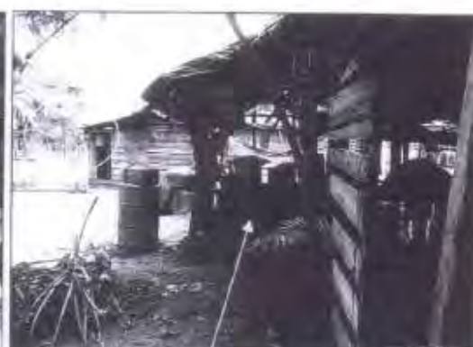
Le groupe électrogène. le captage apparaît en arrière plan à une trentaine de mètres
