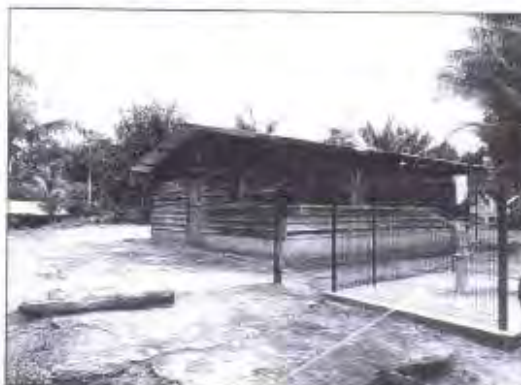
Le captage Frantz Niave Campoe et son environnement immédiat, propre, bien entretenu
